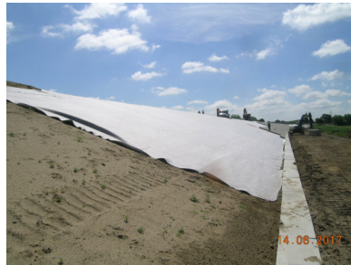
Bild 2: Abdeckung mit Geotextil
