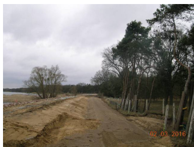
Bild 1: Filtereinbau
