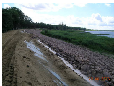
Bild 2: Sicherung der Wasserseite
