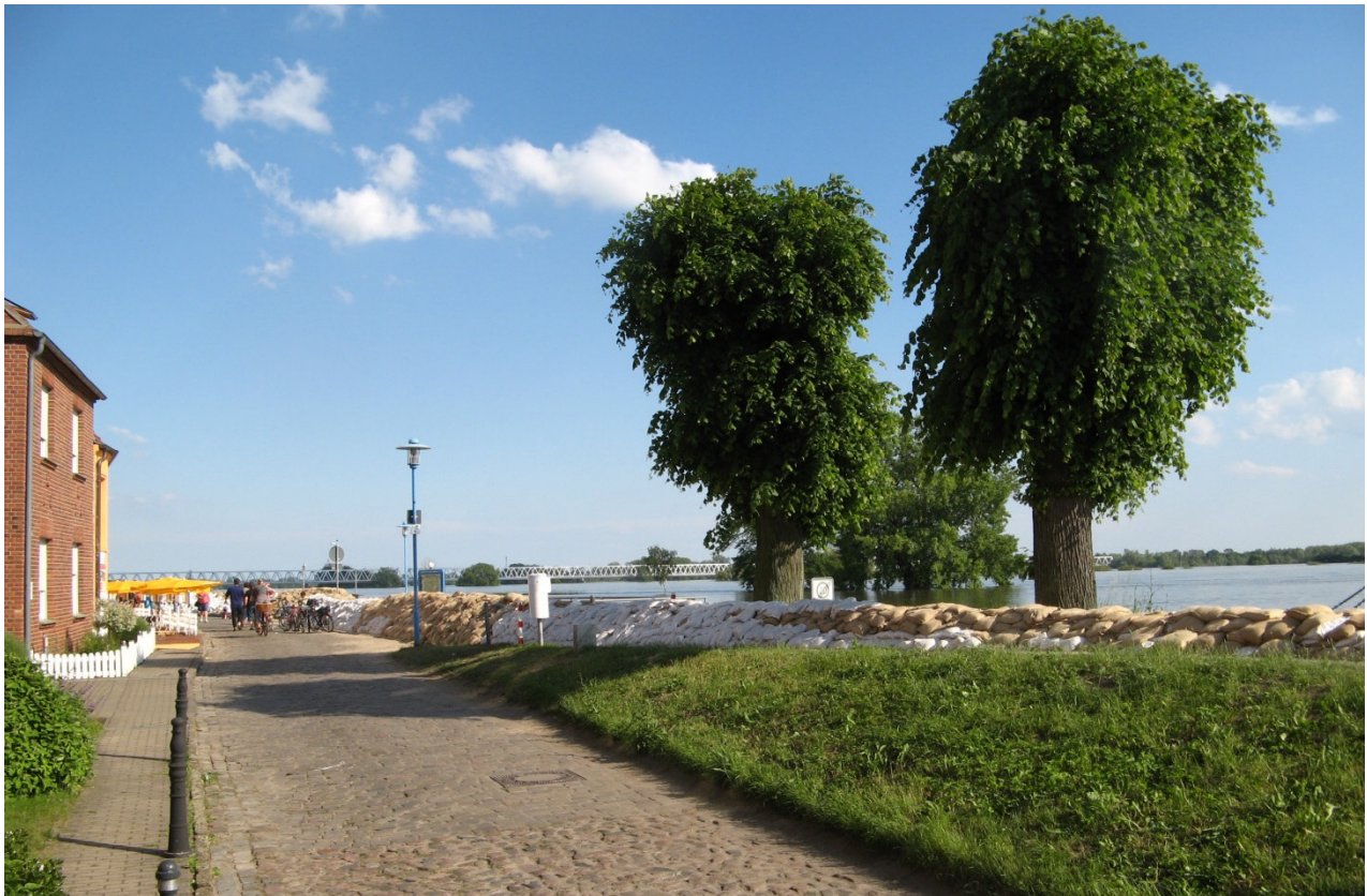
Abb. 2: Elbehochwasser Juni 2013: Sandsackwall entlang der Elbstraße und auf dem Lindendeich
