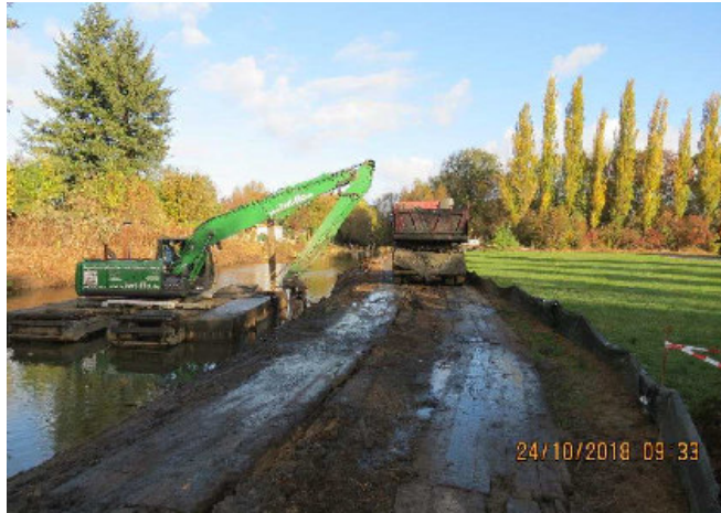
Volzine Station 0+190 zum Bauanfang (Nassbaggerung)
