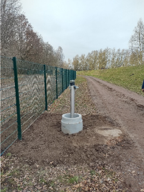
Foto 3: fertig gestellter Entlastungsbrunnen
