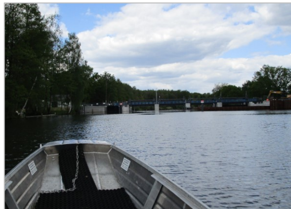
Abb. 9 – Gewässerbefahrung Projektgebiet, Bereich Wehr Hartmannsdorf, Blick flussabwärts (Spree, Gewässer-km ca. 0+173,84), Foto: LfU Referat W 25, März 2019
