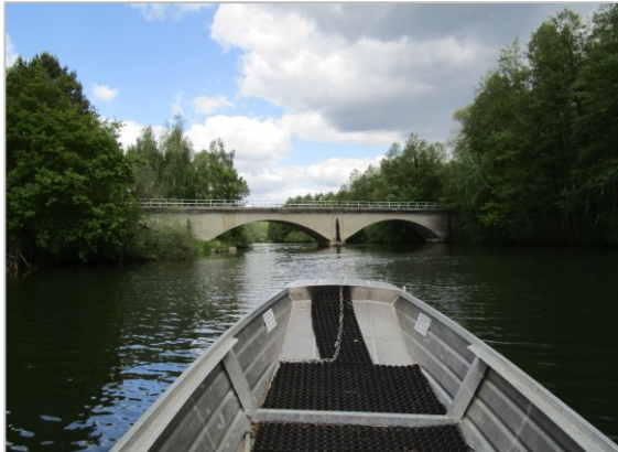
Abb. 6 – Gewässerbefahrung Projektgebiet, Bereich Eisenbahnbrücke, Blick flussabwärts (Spree, Gewässer-km ca. 0+177,05), Foto: LfU Referat W 25, März 2019
