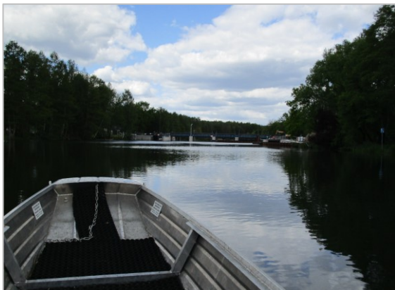
Abb. 8 – Gewässerbefahrung Projektgebiet, Bereich Wehr Hartmannsdorf, Blick flussabwärts (Spree, Gewässer-km ca. 0+173,85), Foto: LfU Referat W 25, März 2019
