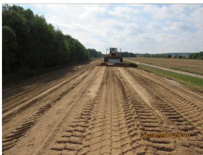
Fertigstellung Stützkörper
