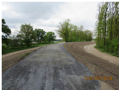
Einbau Schottertragschicht DVW
