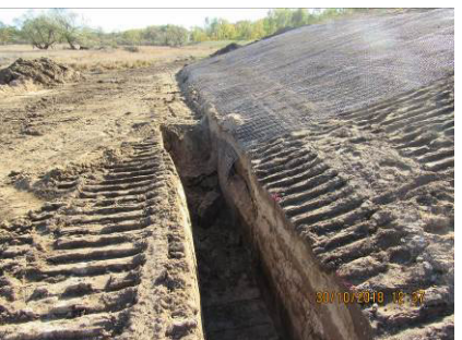
Einbau Biberschutzgitter
