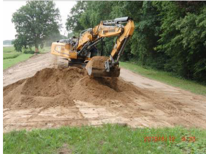
Abbaggern des Altdeiches
