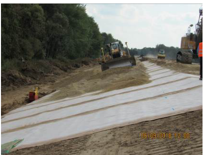
Einbau Dichtungsbahn
