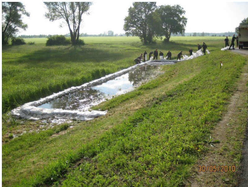
Bild 1 Sicherung der Schadstelle im Hochwasser 2010 LfU – R. Kahlisch
