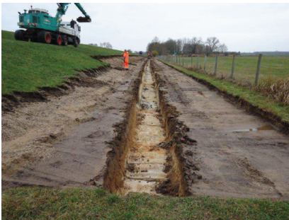
Herstellen Entlastungsschlitz
