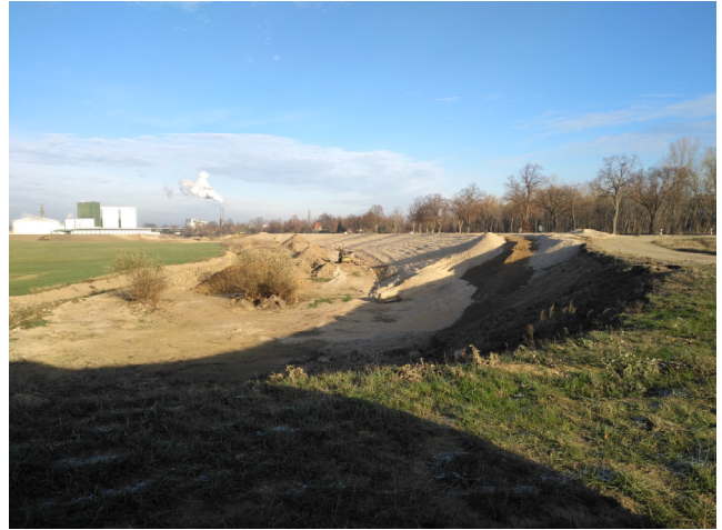
Foto 2: Neudeich vor der Zuckerfabrik der Baumaßnahme
