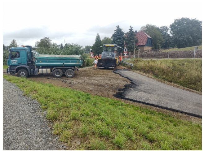
Foto 4: Asphaleinbau
