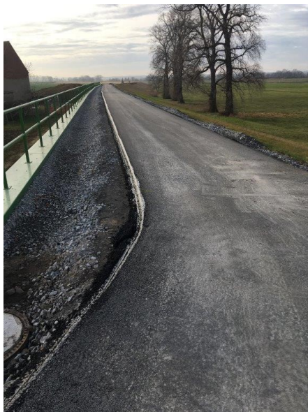
Bild 1: Spundwand an der Deichüberfahrt Altbelgern
