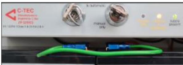
Abbildung 3: Anschließen des grünen Kabels an die Batterien.
