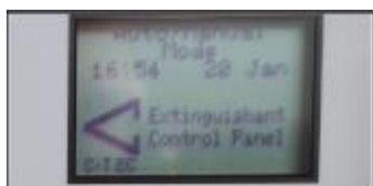
Abbildung 6: Bildschirm auf dem Bedienfeld, System ist aktiv und im Ruhezustand.
