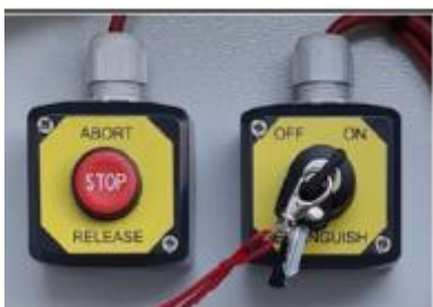
Abbildung 4: Links: Abbruchtaste, Rechts: AUS-/EIN-Schalter des Feuerlöschers.
