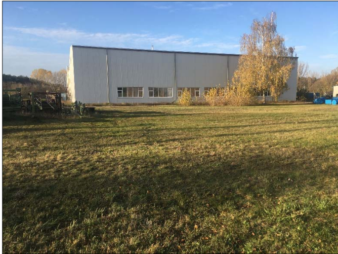
Abbildung 6: Das hallenartige Gebäude wurde hinsichtlich Fledermausvorkommen bewertet. Die Gebäudesubstanz wurde kontrolliert und untersucht.
