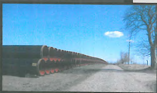
Ein Rohrlager bei Meichow, Lkr. UM – die Stahlrohre liegen für den Bau der Pipeline bereit.
