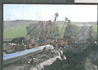
Links: Der Oberbodenabtrag bringt archäologische und natürliche Bodenverfärbungen zum Vorschein – besonders gut erkennbar aus der Luft wie hier bei Neumeichow 10, Lkr. UM. Rechts: Ablageflächen für Mutterboden und Aushubsediment, der Rohrgraben sowie ein seitlicher Arbeitsstreifen – die Breite moderner Erdgasstrassen beträgt 30–36 m.
