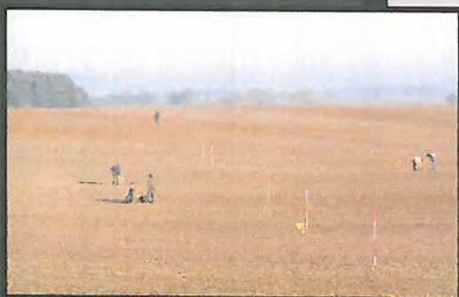
Die beiden zueinander versetzten Reihen von Sondagegruben verlaufen beidseitig der durch Fluchtstangen markierten Mittelachse der künftigen Gasleitung.
